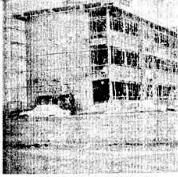
着々進む春日西小学校建設工事
