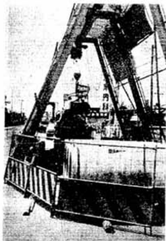
県の流域下水道工事は進んでいます（大和町で）
