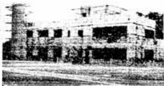
工事を急ぐ南出張所
