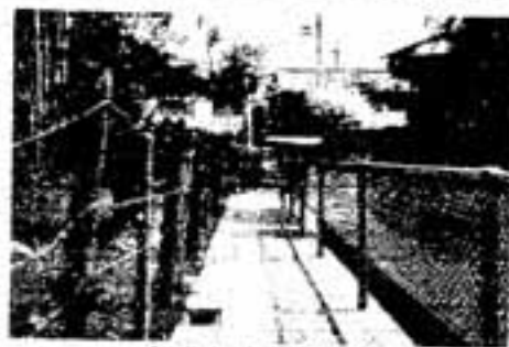
完成した遊歩道
