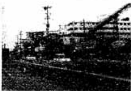
大字須玖字比恵尻(麻生コンクリート付近)
