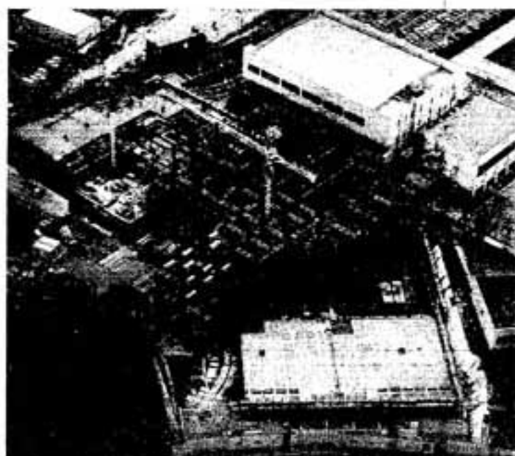
△着々と工事が進むふれあい文化センター
