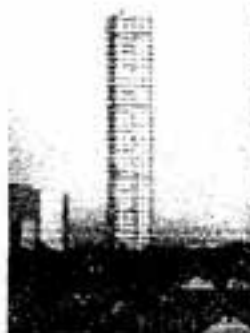
改装が進む高さ80mの煙突
