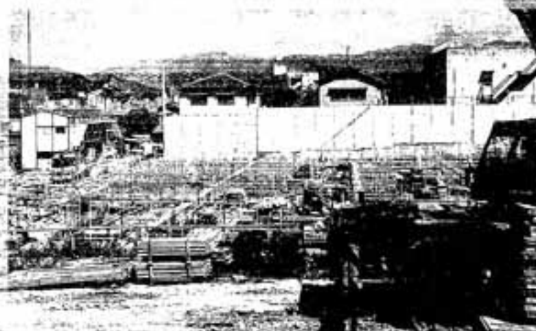
〔仮称）奴国の館建築工事〕△
