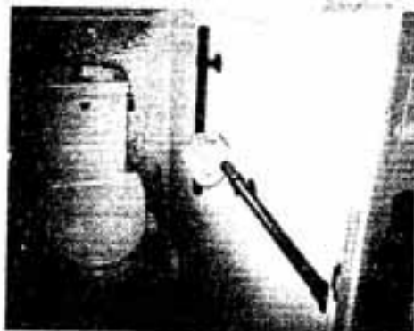
△トイレに手すりを設置
