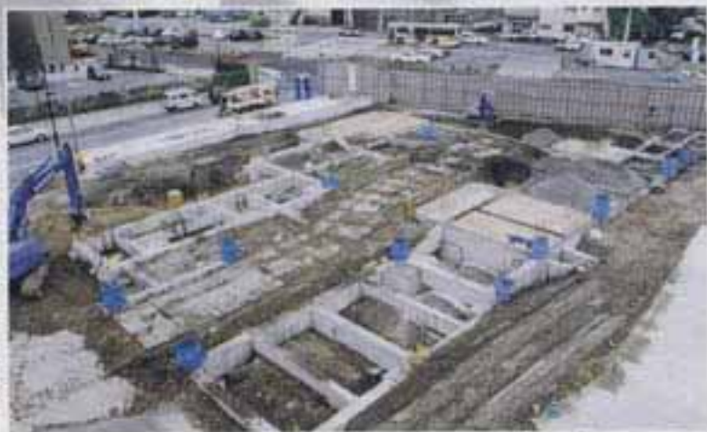
建設中のセンター(仮称)障害者福祉センター
