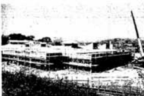
建設中の特別養護老人ホーム
