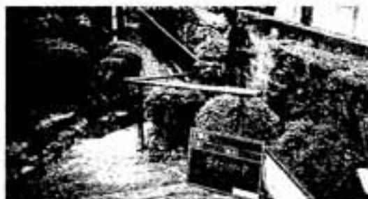
△玄関まで手すりを付けました
