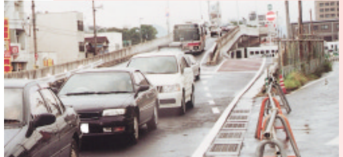
△開通した立体交差道路
