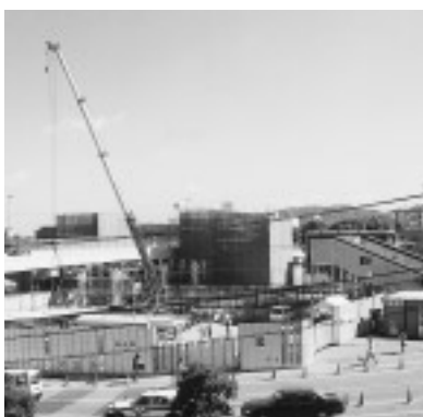
△クレーン後方が工事中の橋上バス停
