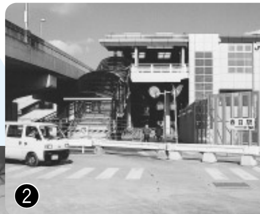
▲光町側から見る新駅舎(西口)。右の囲いの中では、工事が続きます。
