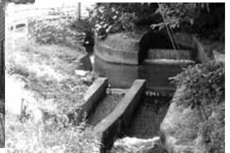
⑥定盤分水施設
