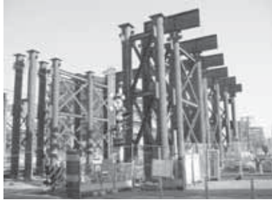
▲西鉄春日原駅付近の施工状況
