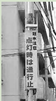
▽冠水状況をセンサーで感知し、回転灯で注意喚起します。
