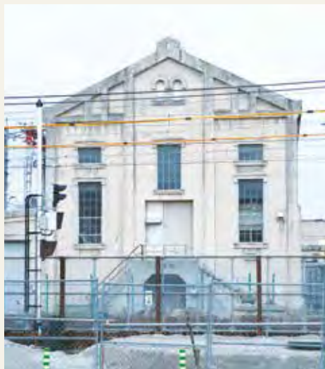
△西鉄春日原駅前の春日原変電所
