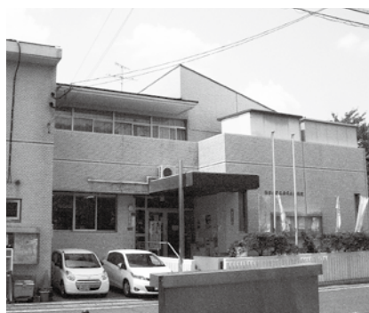
△大規模改修工事を行う春日公園地区公民館
