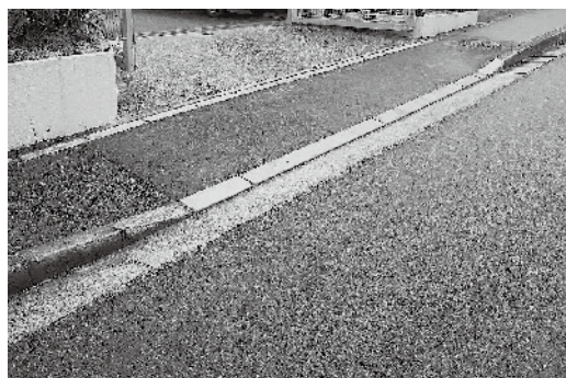
△切り下げ工事後
