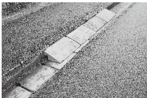
△路上に置かれた乗り入れブロック
