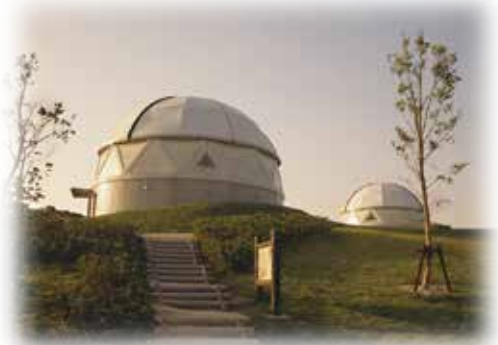
覆屋A・B棟
