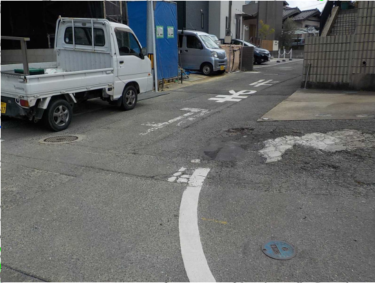
R5.12工事完了
