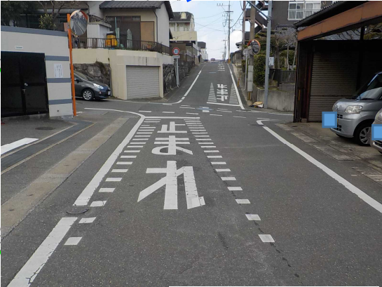
R5.11工事完了
