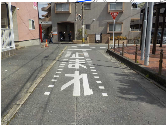
R5.12工事完了
