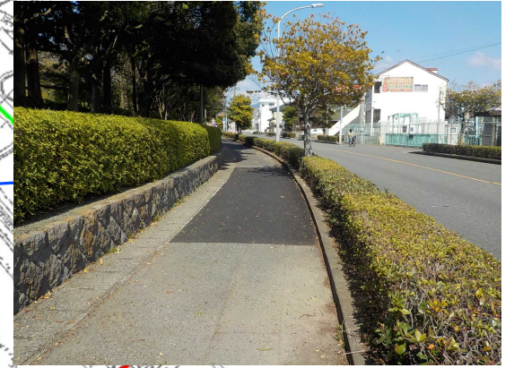
R6.1工事完了
