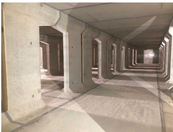
(写真) 小倉第3雨水貯留施設の内部
