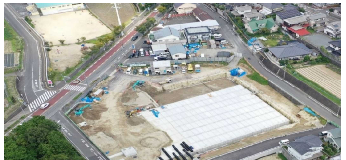
(写真) 小倉第3雨水貯留施設の工事中
