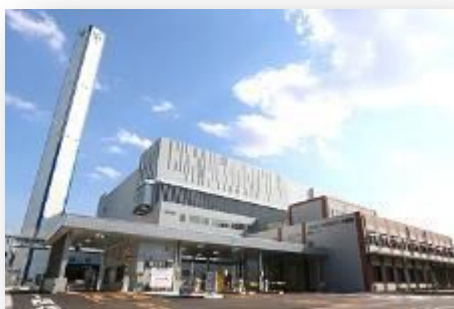
福岡都市圏南部工場（愛称：クリーン・エネ・パーク南部）
