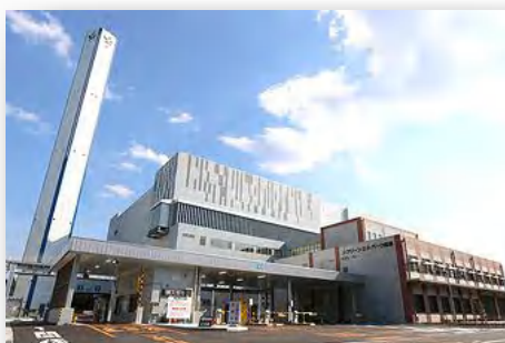
福岡都市圏南部工場（愛称：クリーン・エネ・パーク南部）
