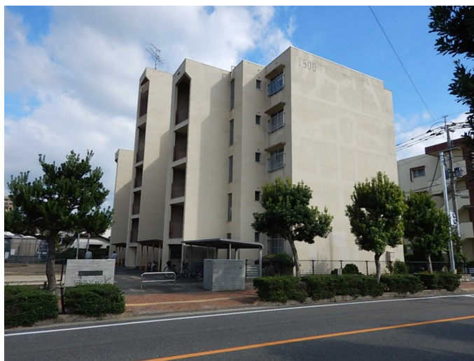
【上白水市営住宅】
